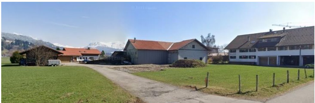
Blick von Nordwesten auf den Änderungsbereich; im zentralen Hintergrund die bestehenden Hofstellen
