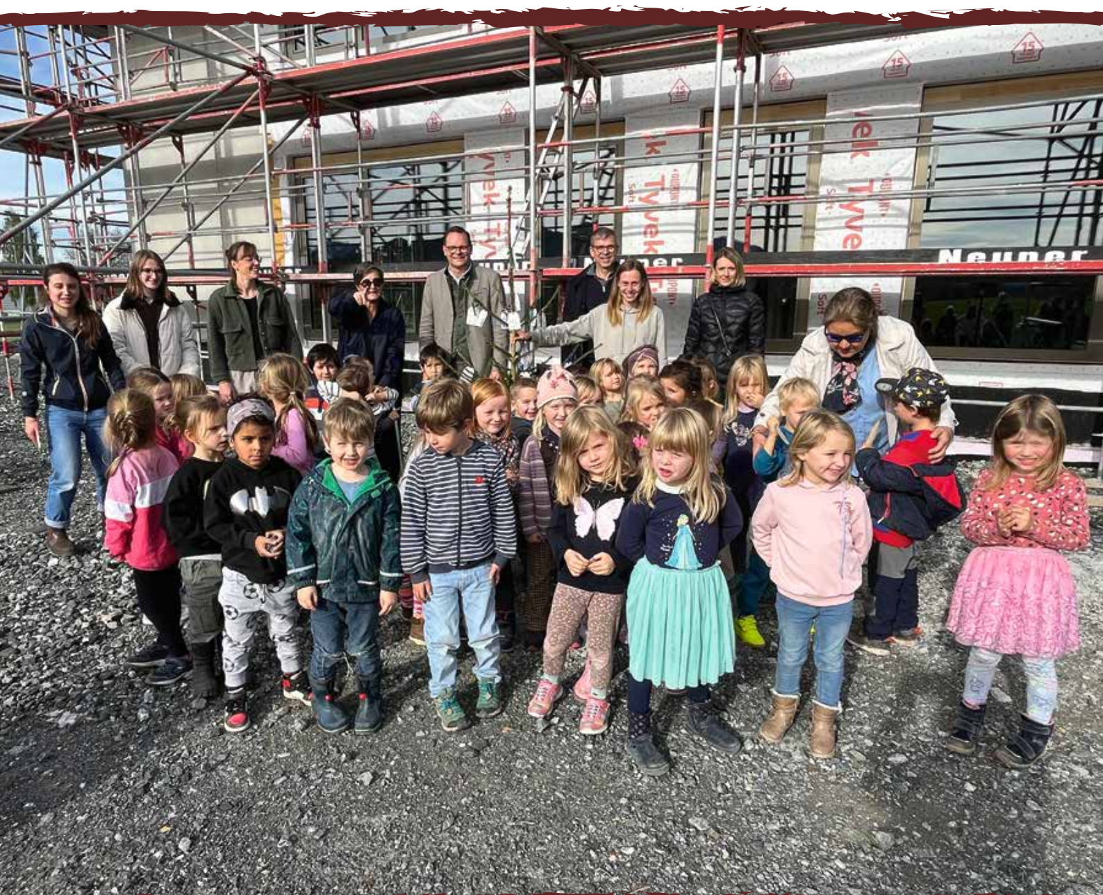
Hebauf im Kindergarten St. Ulrich.
